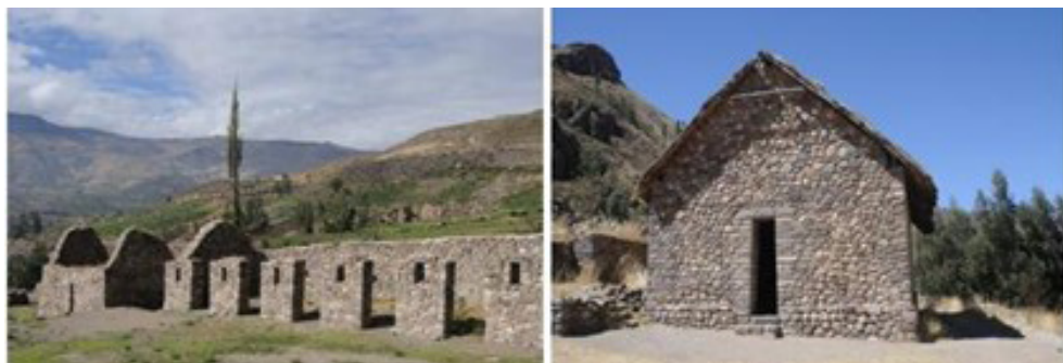
Figura 3. (Izquierda) Kallanka de Uyo Uyo; Figura 4. (Derecha) Estructura denominada «La capilla».
