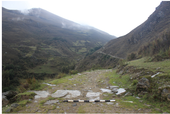
Figura 10. Drenaje en la sección del camino que conecta el tambo inca de Pariash con el petroglifo de Llama Llama y la laguna de Yuraq Cocha (Ordóñez 2019).
