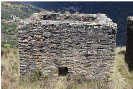
Figura 8. Una de las qollqas mejor conservadas, nótese el pequeño acceso central en la parte inferior del muro (Ordóñez 2019).
