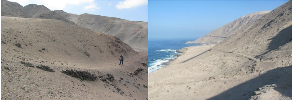
Figura 11. (Izquierda) Camino tipo plataforma en Cerro de Arena, Arequipa.; Figura 12. (Derecha) Camino tipo plataforma cerca de Oscuyo, litoral de Arequipa.
