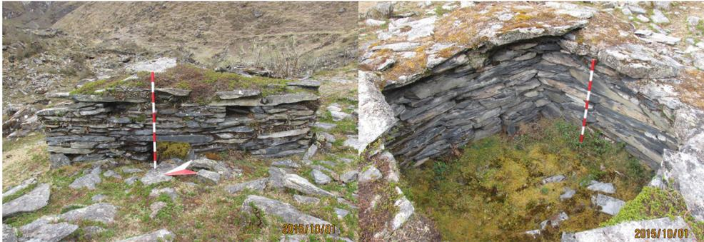
*Foto 5. (Izquierda) Frontis de una vivienda de patrón local (véase los elementos obras de arte el techo, hornacinas y el paramento de acabado regular; Foto 6 (Derecha) El paramento interno de un recinto (véase la técnica de construcción con lajas seleccionadas).*
